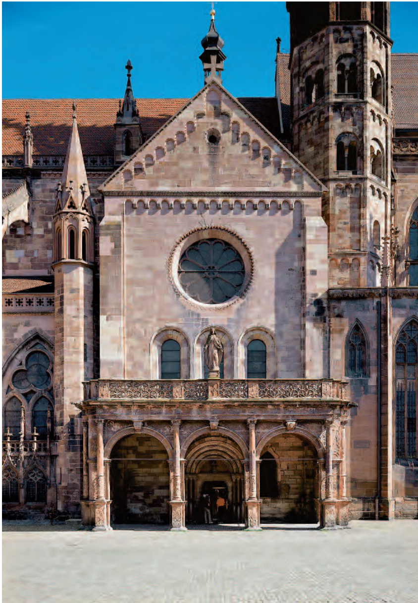
Die spätromanischen Bauteile mit der später hinzugefügten Renaissance-Vorhalle (1620).
